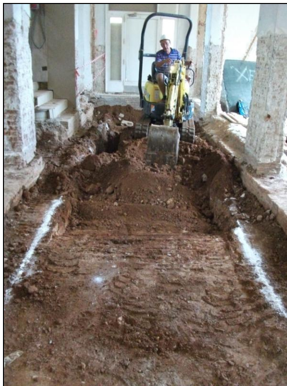
Vista de la màquina realitzant l'obertura de la rasa, Ambit 4.
