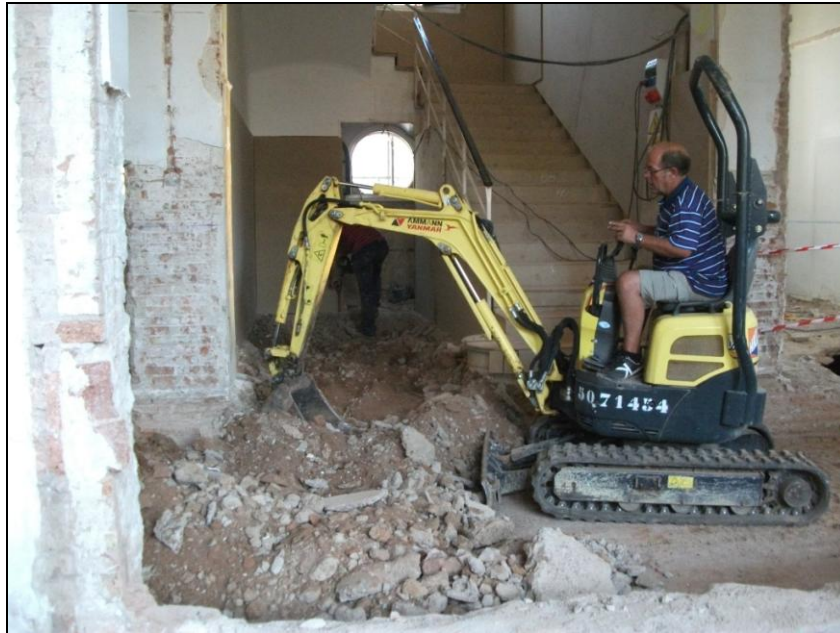
Vista del rebaix de terres realitzat en el forat de l'escala.
