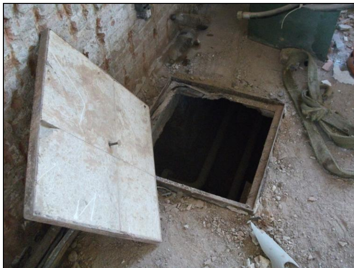
Arqueta localitzada en l'extrem est de l'Àmbit 3.
