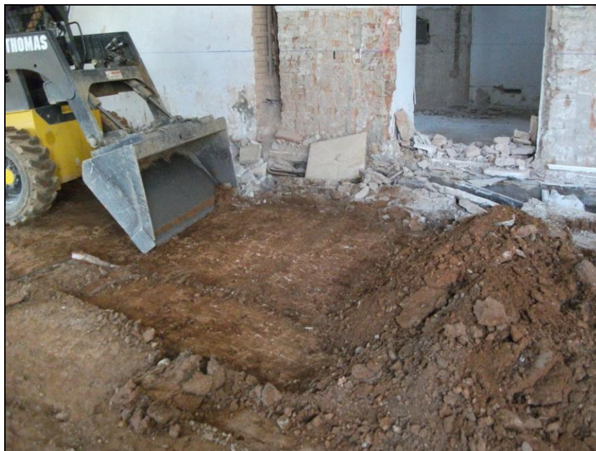
Vista de la màquina realitzant el rebaix i neteja del subsòl geològic, Àmbit 3.
