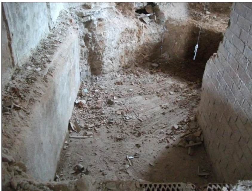
Vista del forat de l'ascensor i del seu eixamplament.
