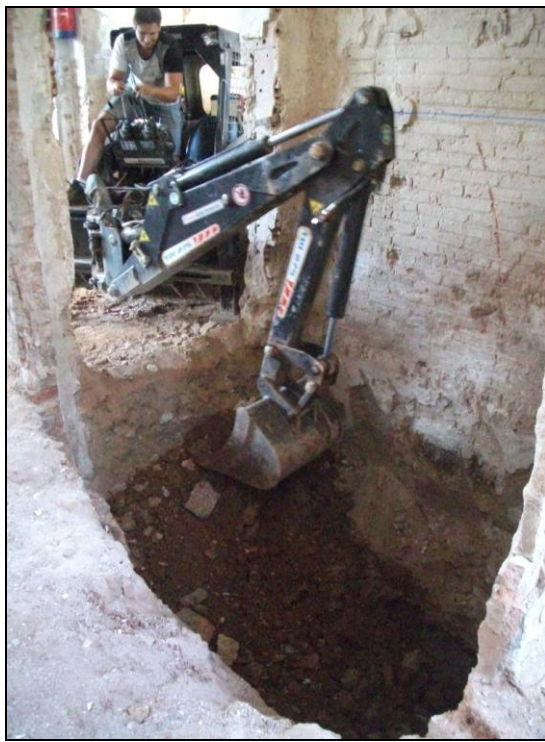
Vista del rebaix en l'antic forat de l'ascensor.
