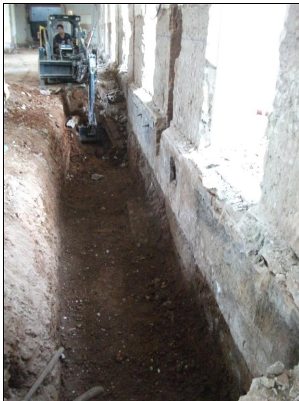
Vista de la màquina realitzant l'obertura de la rasa.
