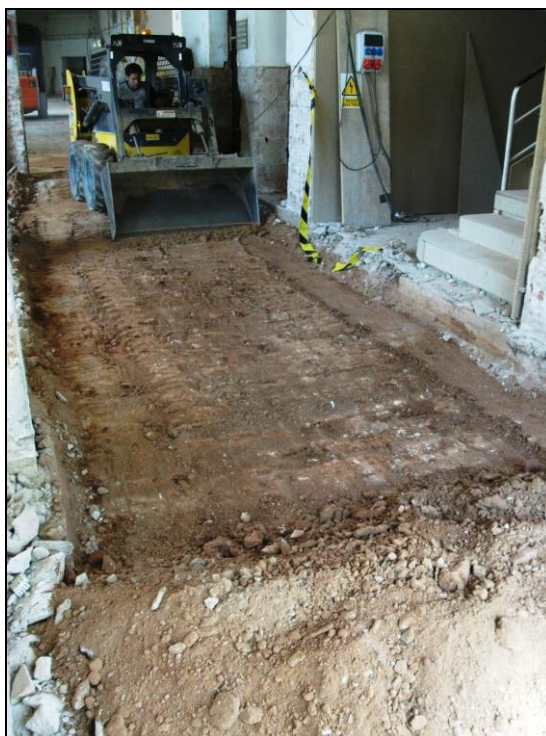
Vista de la màquina realitzant el rebaix i neteja del subsòl geològic, Àmbit 4.
