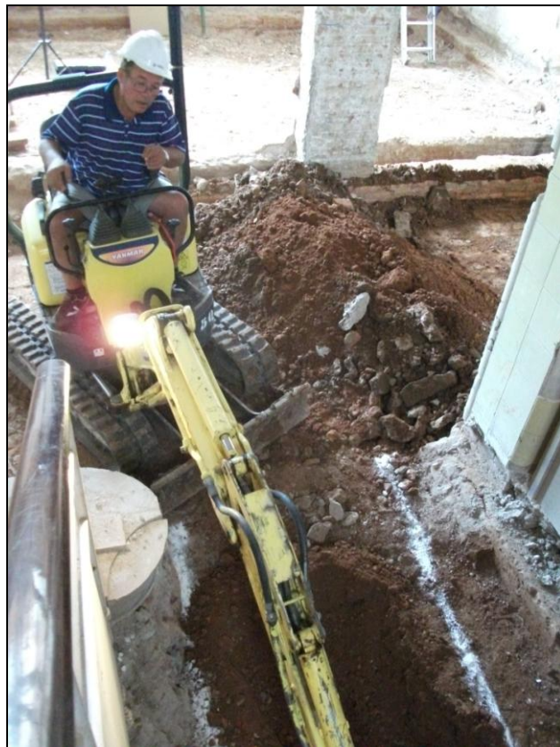
Vista de la rasa ubicada en el forat de l'escala, Àmbit 4.
